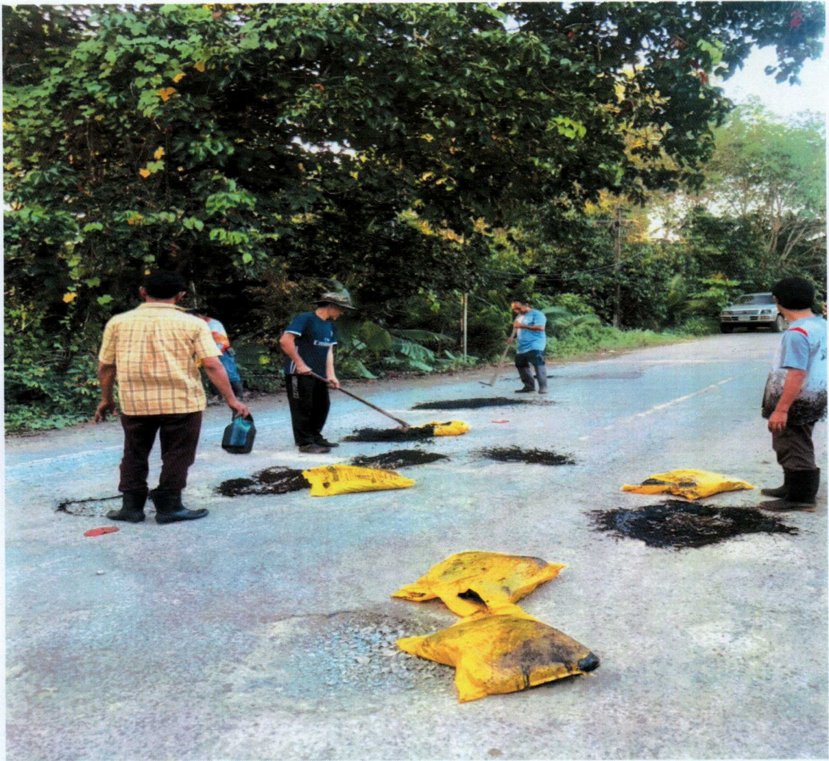
ภาพการซ่อมแซมถนน สายท่าแพ - ดาหลำ ม.4 ม.8 ม.9
