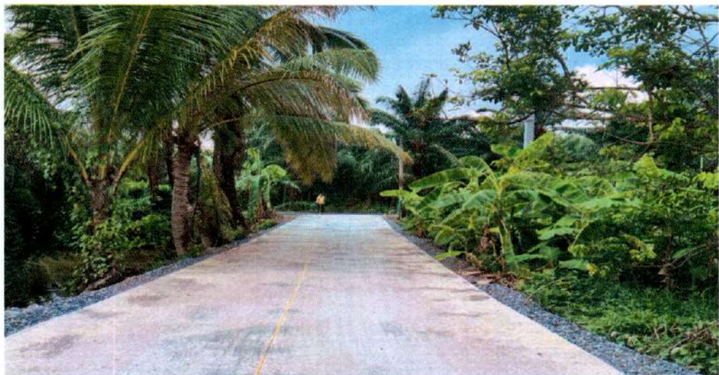
ภาพโครงการก่อสร้างถนนผิวจราจรคอนกรีตเสริมเหล็ก ซอยปลักการัง 2 หมู่ที่ 5 (งบข้อบัญญัติ 95,500 บาท)
