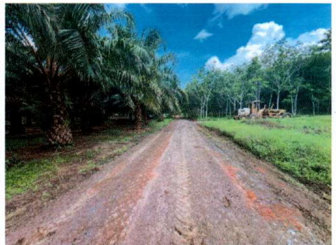
ภาพโครงการ เกรต บด อัดถนนผิวจราจรลูกรัง หินคลุก และหินผุ ภายในตำบล
